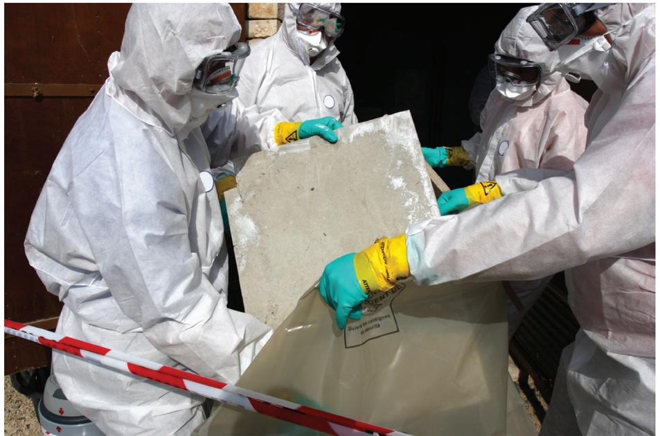
des vieux produits qui contenaient de l'amiante dans le passé comprennent le fini grené des plafonds texturés, les carreaux pour sol ou les feuilles de revêtement de sol en vinyle, les mastics de vitrier, les pâtes à joint pour cloisons sèches, le ruban à conduits pour les appareils de chauffage et le stucco. Certains matériaux ignifuges et acoustiques contiennent également de l'amiante.
